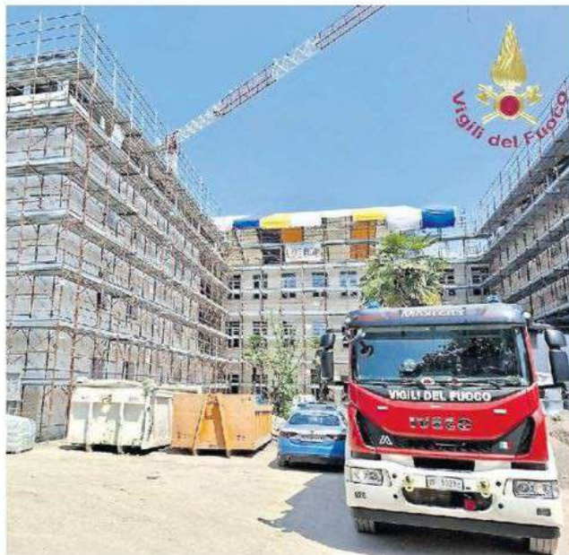
I VIGILI DEL FUOCO L'intervento nel cantiere tra via Sant'Eufemia e via Belzoni
