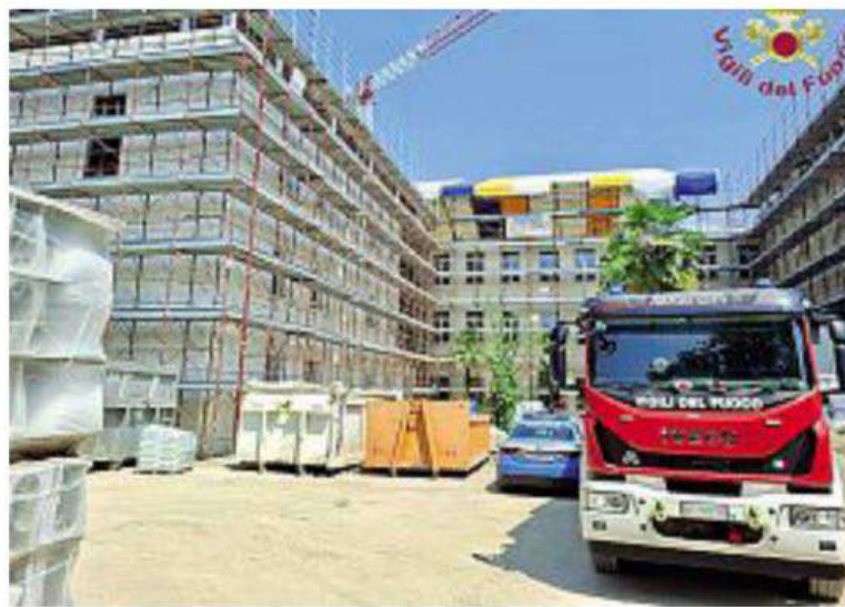
L'intervento Vigili del fuoco al cantiere dello studentato ieri
