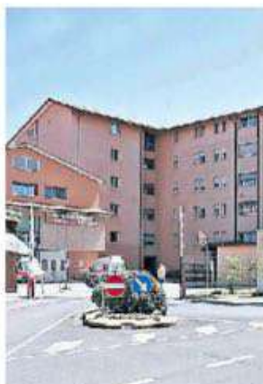
L'OSPEDALE di Este, lavori fermi per lo sciopero Manelli
