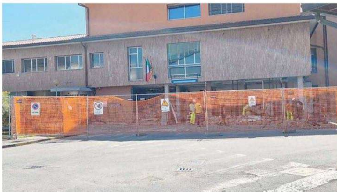
Il cantiere dei lavori all'interno dell'ex complesso ospedaliero di Este in via San Fermo
